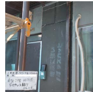
外部からの補強（耐震補強壁）
